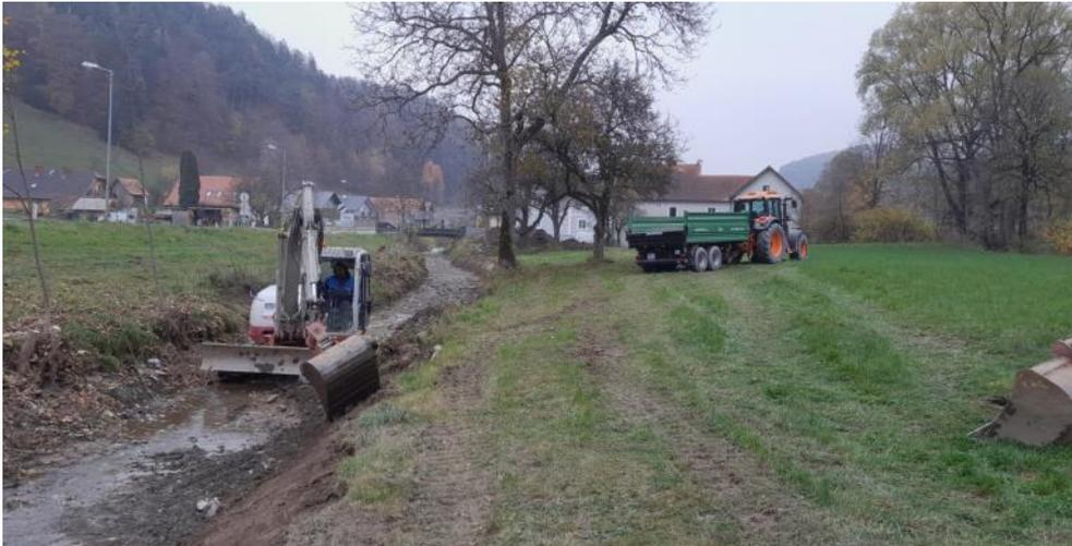
Der Weizbach wurde an einigen Stellen von einengenden Bewuchs und übermäßigem Geschiebe befreit, damit das Risiko für Schäden durch Hochwasser verringert wird.
